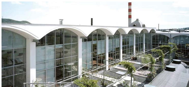
La corte centrale con gli affacci dei loft. Ogni unità ha uno spazio esterno, privatizzato e contraddistinto da un pergolato in Jasminum, affacciato sulle volte con le prese di luce del museo.
