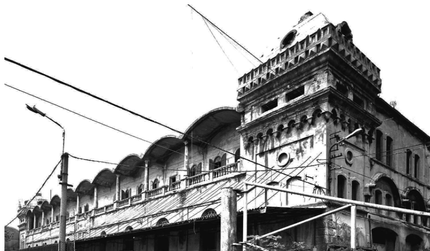
Prospetto principale e vista interna del loggiato dell'ex cementificio di Alzano Lombardo prima e dopo i lavori di risanamento.
